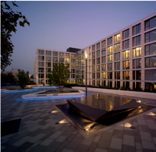
Bei der Beleuchtung setzt R+V auf umweltfreundliche LEDs und ein intelligentes Konzept.
