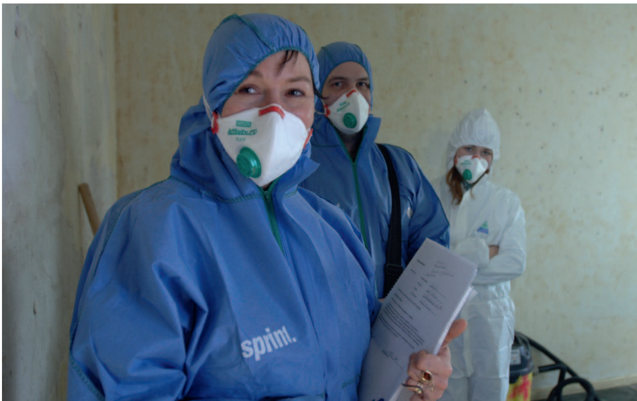
Mitarbeiter des R+V-Sanierungsspezialisten Sprint bei ihrer Arbeit in einem beschädigten Gebäude.
